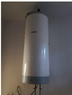
Obrázok 7. Zásobníkový elektrický ohrievač
