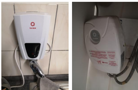
Obrázok 10. Prietokové ohrievače
