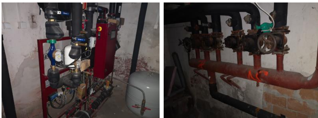
Obrázok 6. KOST a rozdeľovač ÚK
